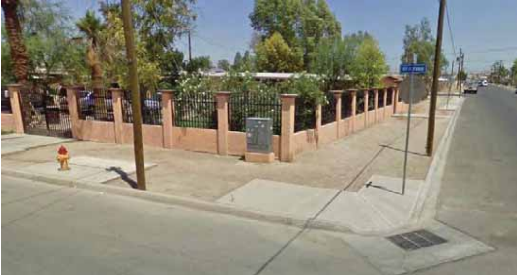
Dispone de rampa para silla de ruedas, aunque no haya banqueta.
