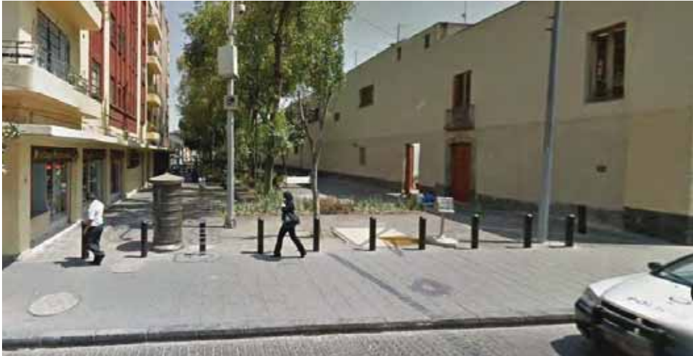
Es una vialidad solamente de uso peatonal. Los bolardos limitan el paso de automóviles.
