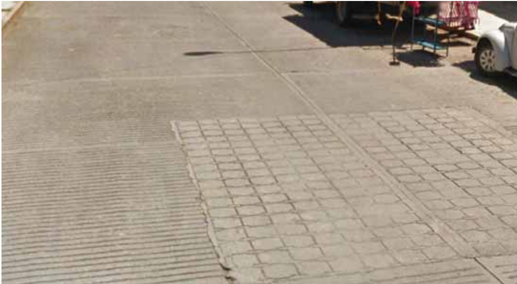
Calle con concreto. En una parte se observa que la textura parece empedrado o adoquinado, pero es concreto.
