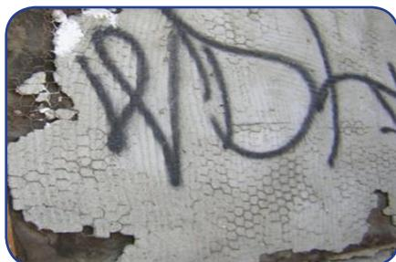
Techos de lámina de asbesto.
